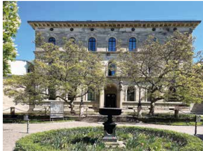
Alte Polizeidirektion, erbaut als großherzoglich-badisches Amtshaus, seit 2009 Ärztehaus Vincenti | Old police station, originally a Grand Duchy of Baden civic building, since 2009 the Vincenti Medical Centre | Старое здание полиции, изначально построенное в качестве здания управления Великого герцогства Баденского, в котором с 2009 года расположен медицинский центр Vincenti
