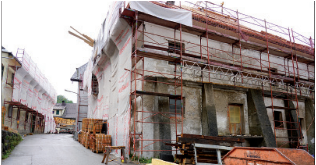
Im Ortszentrum von Lauffen werden derzeit zwei der ältesten und größten Häuser vorläufig erst außen saniert.
