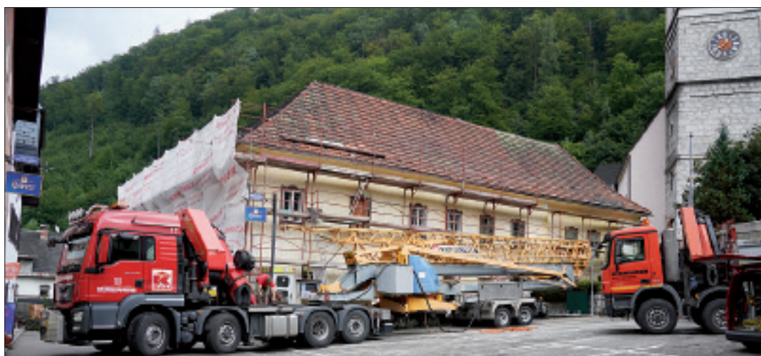
Ein zweiter Kran wird für die Dach- und Fassadensanierung des Gemeindehauses aufgestellt.
