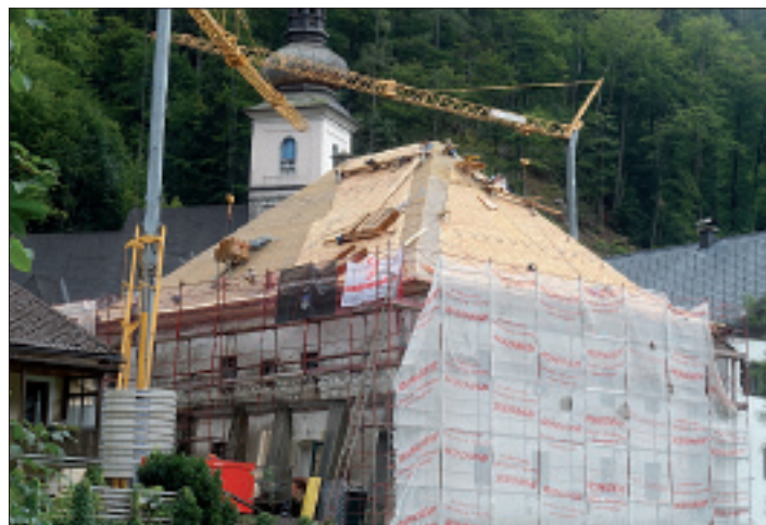
Das ehemalige Gasthaus „Zu den drei Mohren“ wird derzeit mit Lärchenschindeln gedeckt.
