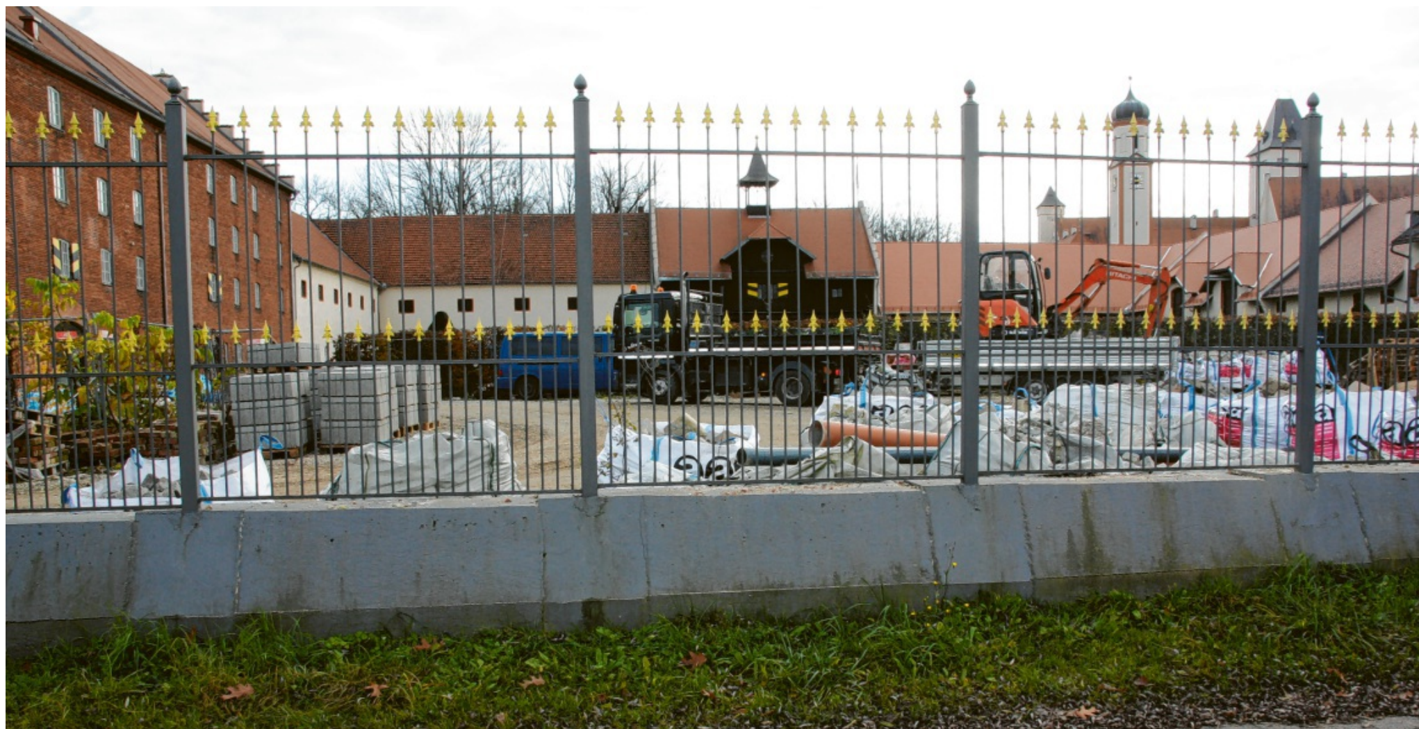
Ein Restaurant soll auf dem Wirtschaftshof des Schlosses Hofheggenberg gebaut werden. Dieses soll den abgerissenen Brauereistadel ersetzen und damit den ursprünglich von vier Seiten umbauten Hof wieder komplettieren.
