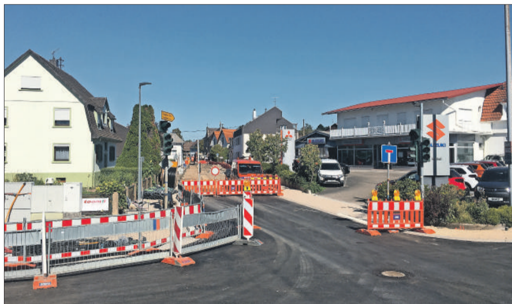
Sanierung der Karlsruher Straße: Bauabschnitt 2 im Bereich von Steinhauerweg bis kurz vor das Rathaus.
