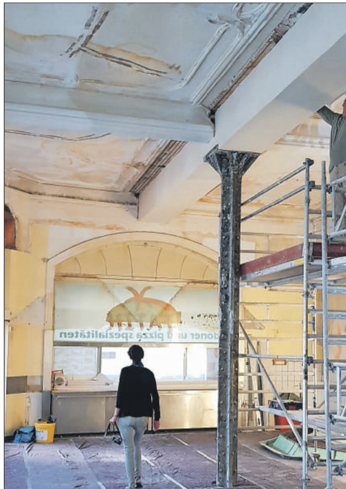
Edles Ambiente: Im Erdgeschoss sind die bislang abgehängten Stuckdecken freigelegt worden.
