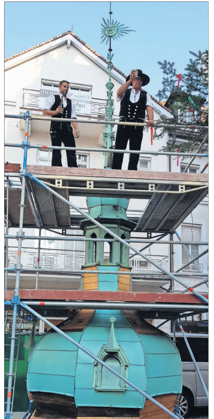
Die Zimmerleute tragen den Richtspruch vor. Der Turm soll heute wieder aufs Dach des Gebäudes gehievt werden.
